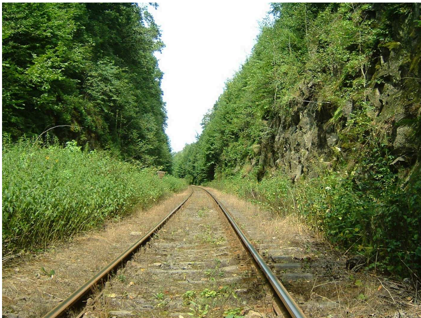
Ryc. 1. Wykuty w skale „wąwóz” kolejowy w Górze Koguciej. Fot. A. Kordasiewicz
