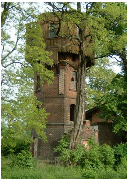
Ryc. 4. Niszcząca od lat wieża ciśnień. Fot. A. Kordasiewicz
