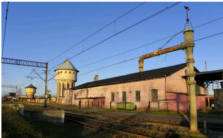
Ryc. 7. Lokomotywnia z lat 70. XIX w. oraz jeden z nielicznych zachowanych żurawi do napełniania wodą zbiorników lokomotyw parowych (po prawej). W tle dwie wieże ciśnienia. Fot. P. Dominas
