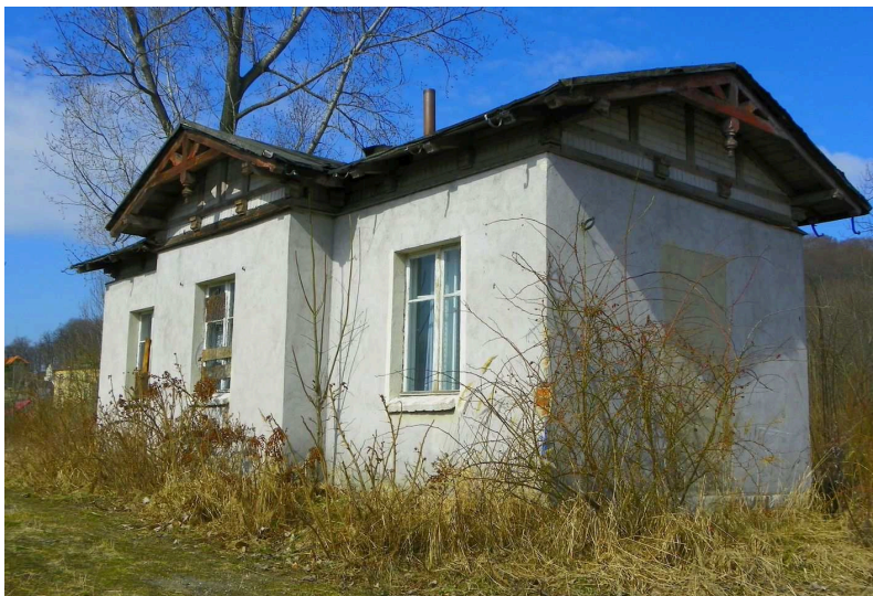
Ryc. 12. Dworzec dawnego przystanku Byczeń. W części szczytowej zachował dawne, szkieletowe elementy konstrukcyjne oraz ich wypełnienie cegłą. Stan w 2010 r. Fot. P. Dominas
