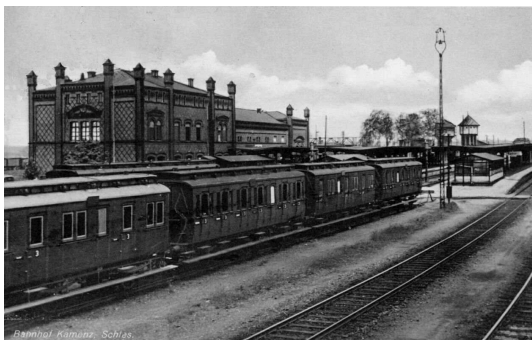
Ryc. 5. Dworzec w Kamieńcu Ząbkowickim na pocz. XX wieku, po wybudowaniu zadaszonych peronów i przejścia podziemnego w 1906 r. Pocztówka ze zbiorów prywatnych
