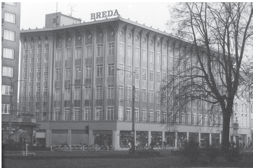
Ryc. 9. Dom handlowy „Breda” w Opawie od południowego zachodu (fot. Bogusław Czechowicz).
