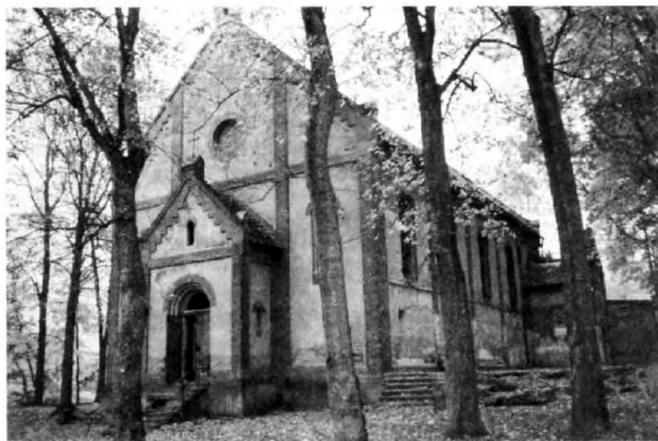
Fot. 3. Kościół poewangelicki w Chełmsku Śląskim. Na ścianie bocznej widoczne ślady po rozebranej szatni.
