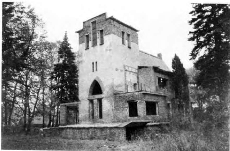
Fot. 6. Kościół poewangelicki w Krzeszowie. Widok od strony wieży. Dobrze widoczne są dobudówki z lat siedemdziesiątych, m.in. wjazd do garażu.
