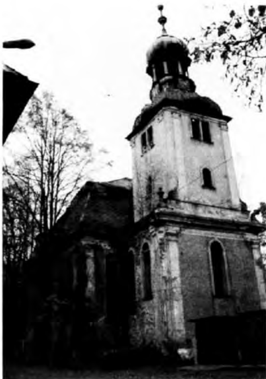
Fot. 9. Kościół poewangelicki w Miszkowicach. Stan obecny.
