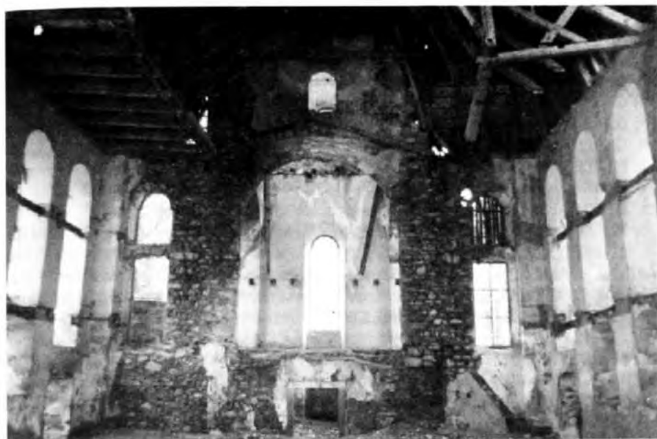
Fot. 11. Wnętrze kościoła poewangelickiego w Miszkowicach. Stan obecny.
