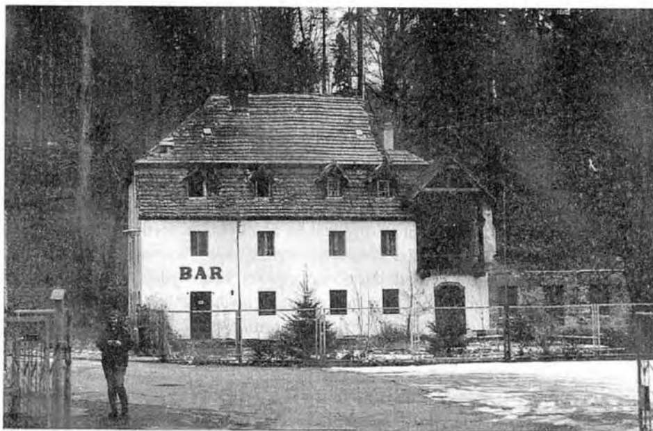
Fot. 3. Złoty Las – budynek z XVIII w. związany z działalnością tamtejszego gwarectwa.
