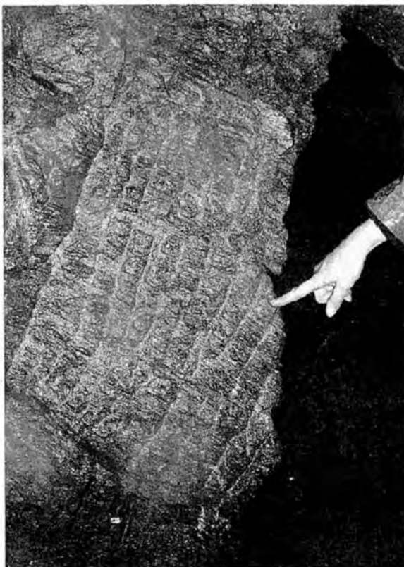
Fot. 6. Walim – ślady ręcznego urabiania skał na ociosie wyrobiska.
